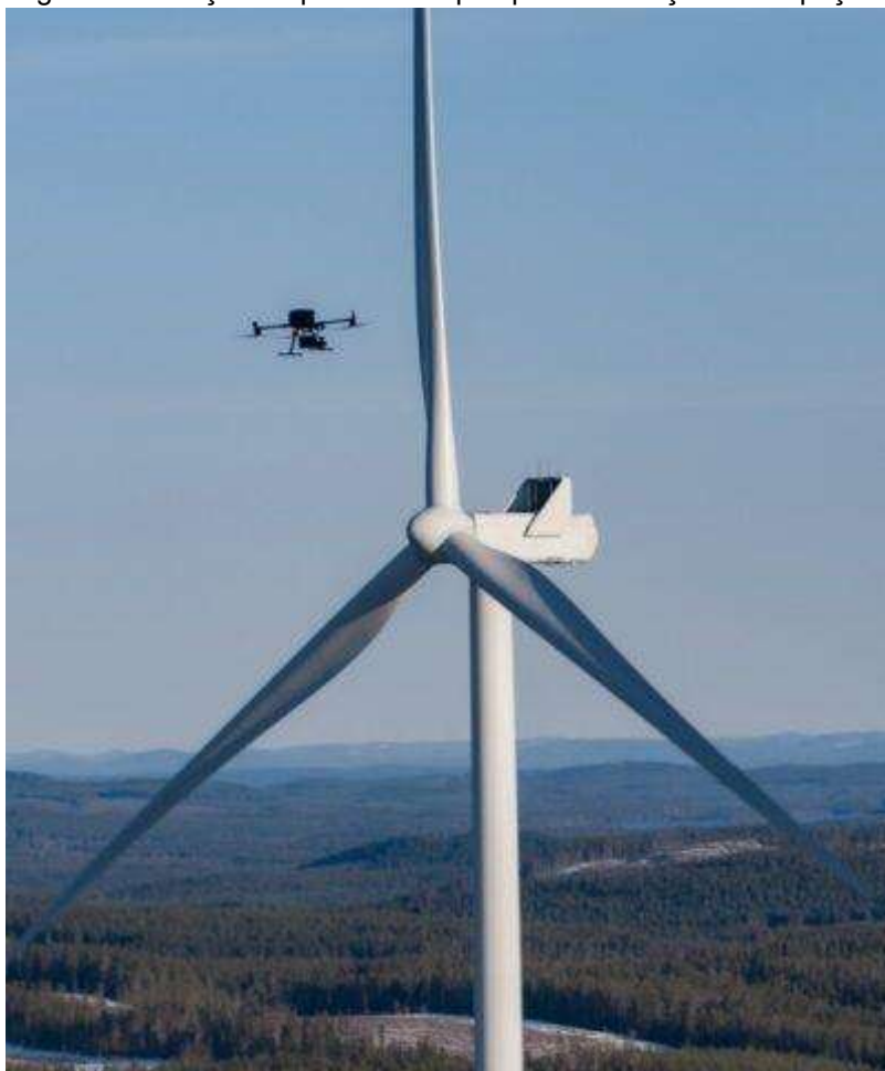
Figura 1 - Posição de parada das pás para realização de inspeção.
