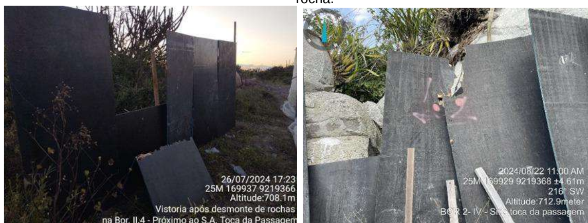
Figuras 5 e 6. Danos causados nas medidas protetivas decorrentes da atividade de desmonte de rocha.
