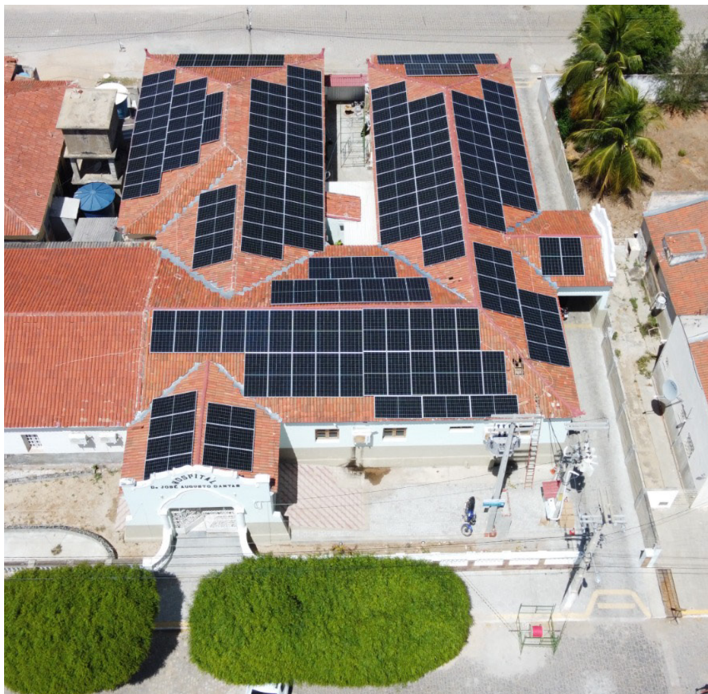
Elera Renováveis promove instalação de Sistema Fotovoltaico no Hospital Dr. José Augusto Dantas, em Parelhas/RN.
