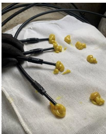
Figura 5 – Simulação da saída da graxa pelas mangueiras do Sistema de lubrificação automática
