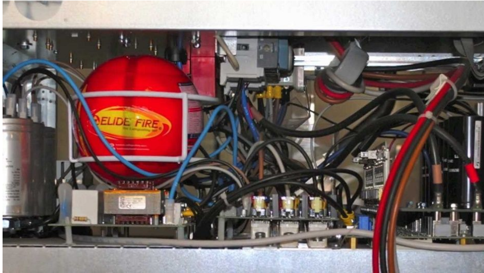
Figura 3 - Bola Extintora ABC Automática
