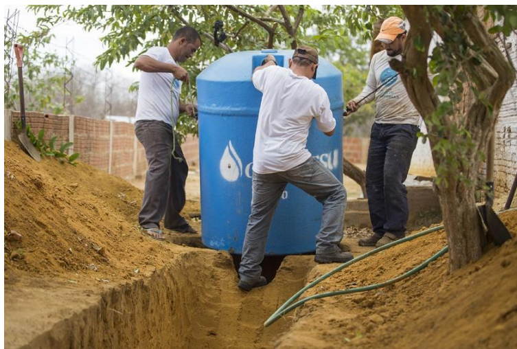
Figura 3 – Fossa séptica em instalação pela comunidade de Açussena, município de João Câmara.
