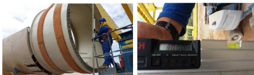
Figuras 13 e 14 – Checagem do nivelamento da aduela (Fonte: Dois A Tower System).
