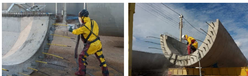
Figuras 11 e 12 – Execução da hidrodemolição (Fonte: Dois A Tower System).
