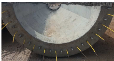
Figura 1 - Tirantes de uma aduela pré-moldada de concreto (Fonte: Dois A Tower System).
