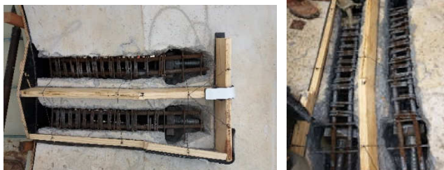
Figuras 19 e 20 – Detalhe instalação de formas à esquerda e aplicação do graute à direita (Fonte: Dois A Tower System).
